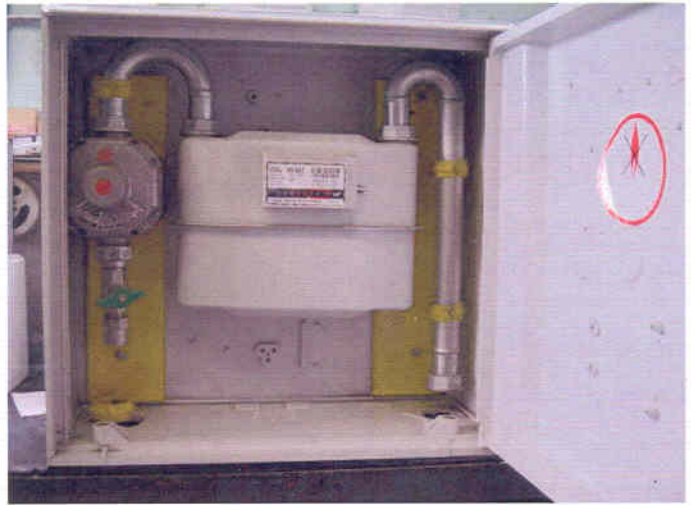
3. sz. ábra Nyomákszabályozó és gázmérő védőszekrényben, amely megvédi a csapadéktól
